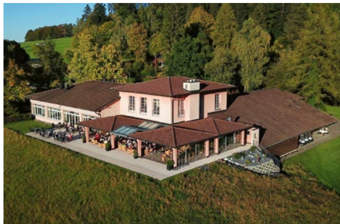
Renoviertes und ausgebautes Clubhaus
