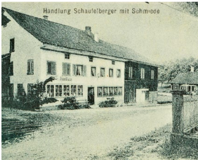
Handlung und Wirtschaft zur Ziegelhütte, rechts im Bild die ehemalige Schmiede an der Oberdorfstrasse, um 1900.
