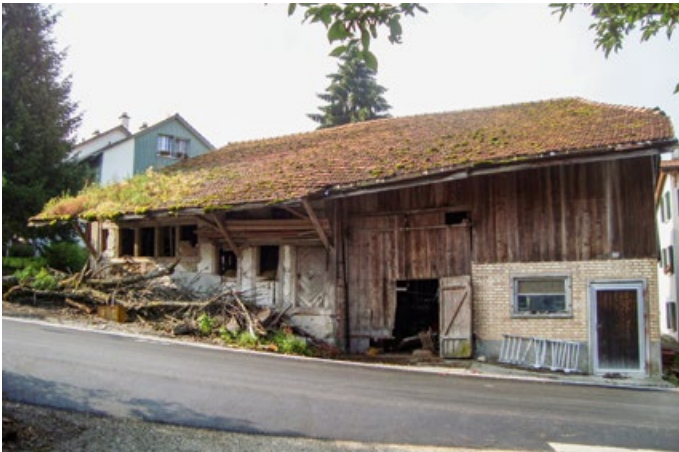
Gebäude kurz vor dem Abbruch im Jahr 2011
